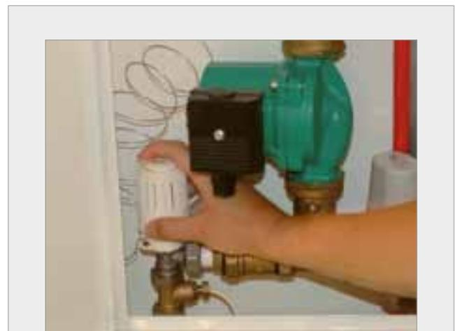
Температура подачи установки на излучающих панелях определяется позицией термостатической головки R462L в соответствии с приведенной ниже таблицей. Точность регулировки очень высокая (около ± 1°C), поэтому рекомендуется проводить настройку при режимной работе установки. Для избежания возможного непроизвольного смещения проведенной корректировки, можно зафиксировать головку при помощи соответствующего металлического стопора.
