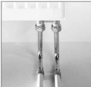
Подключение радиатора с использованием монтажной трубы
