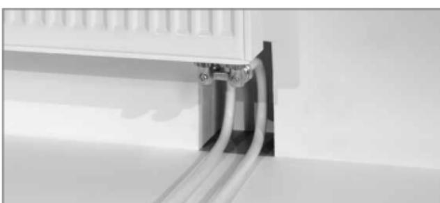
Подключение радиатора из стены
