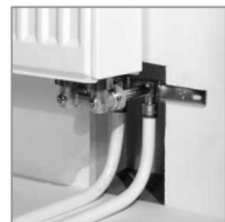
Подключение радиатора с использованием настенной монтажной планки
