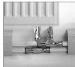
Подключение радиатора с использованием двойного тройника при плинтусной проводке
