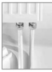
Подключение радиатора с использованием направляющего уголка
