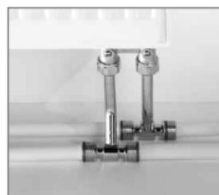
Подключение радиатора с использованием проходной трубы
