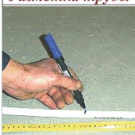
При помощи рулетки отмеряется необходимая длина трубы и в месте будущего отреза ставится метка фломастером, маркером или карандашом. Не допускается наносить риски острыми предметами, повреждающими верхний слой трубы
